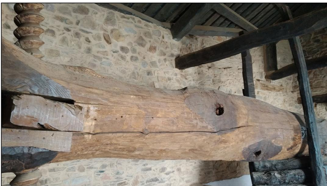
Foto: viga de castaño de una sola pieza.
